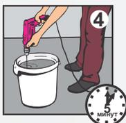
**4** Для подготовки раствора залейте водопроводную воду комнатной температуры в чистую ёмкость из расчёта 4,5 - 5,5 л воды на 1 мешок (25кг). Засыпая сухую смесь в воду, перемешивайте раствор дрелью со специальной насадкой на низких оборотах до получения однородной массы. Подождите 5 минут, после этого перемешайте вторично. Время пригодности раствора к работе не менее 3 часов.
